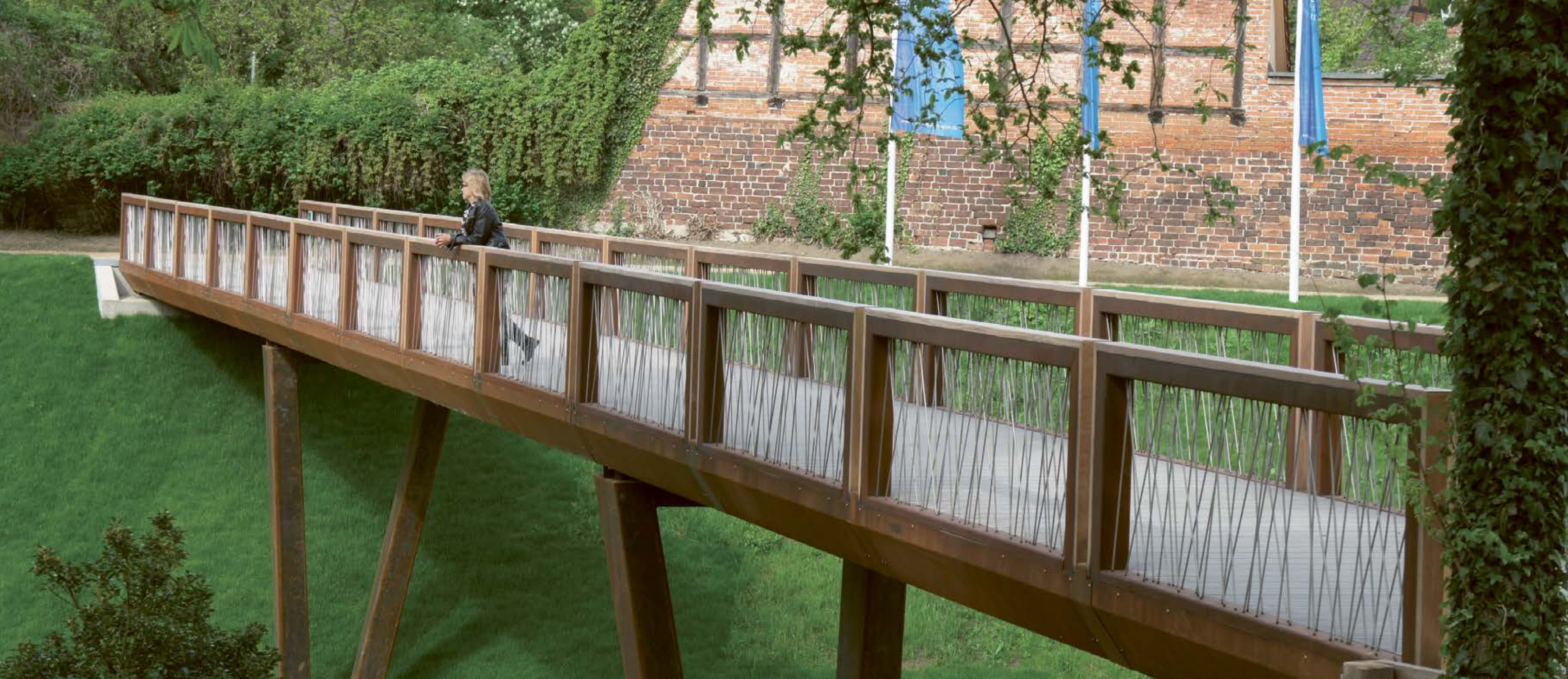
Die 40 Meter lange Crossline Brücke, die man für die Bundesgartenschau 2015 in Havelberg über die Flethe platziert hatte, war in 3 Segmenten aus den
