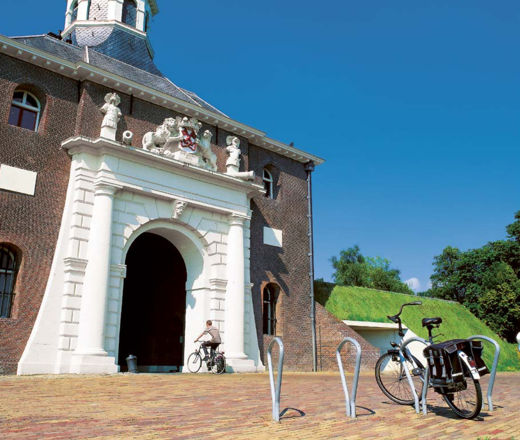
Im historischen Zentrum von Leiden (NL) kommen die Clip Fahrradbügel in großem Stil zum Einsatz. Die einfache und schlichte Form passt sowohl zu alten Baudenkmalern als auch zu moderner Architektur.
