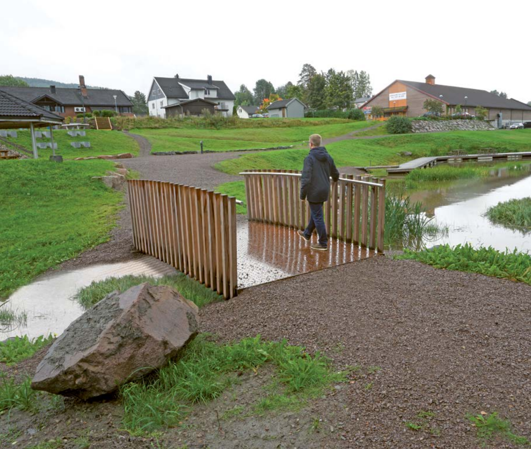
Bei dieser im norwegischen Hvitvingfoss realisierten Solo Brücke mit einem Geländer aus FSC-Harholz bieten die Noppen von Cordeck® zusätzliche Rutschfestigkeit.
